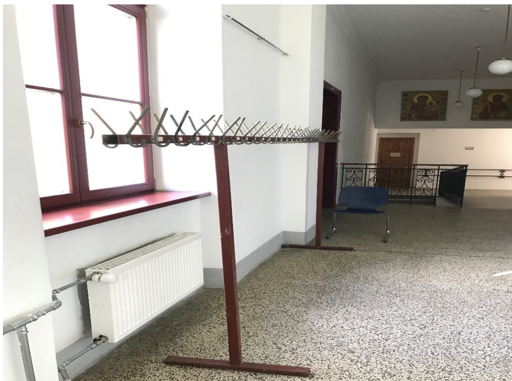
Фото 3.1 Коридор 1 поверху. Небезпечний вішак для одягу.
