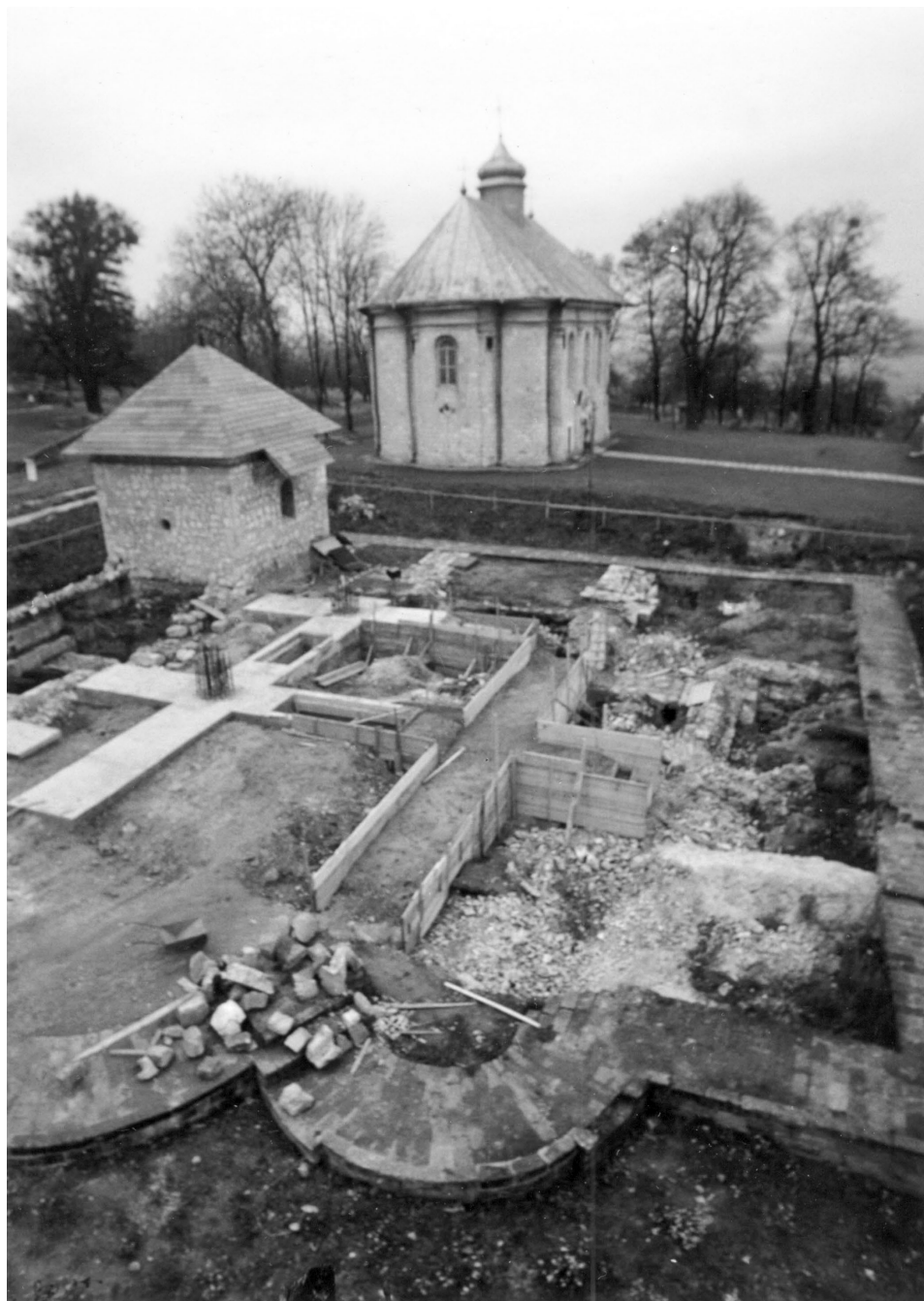
Фрагмент фундаменту Успенського собору в Галичі, залитий бетоном (фото з колекції Ю. Лукомського)
