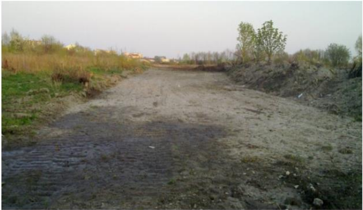
Будівельні роботи на Рясівській у 2011 році
