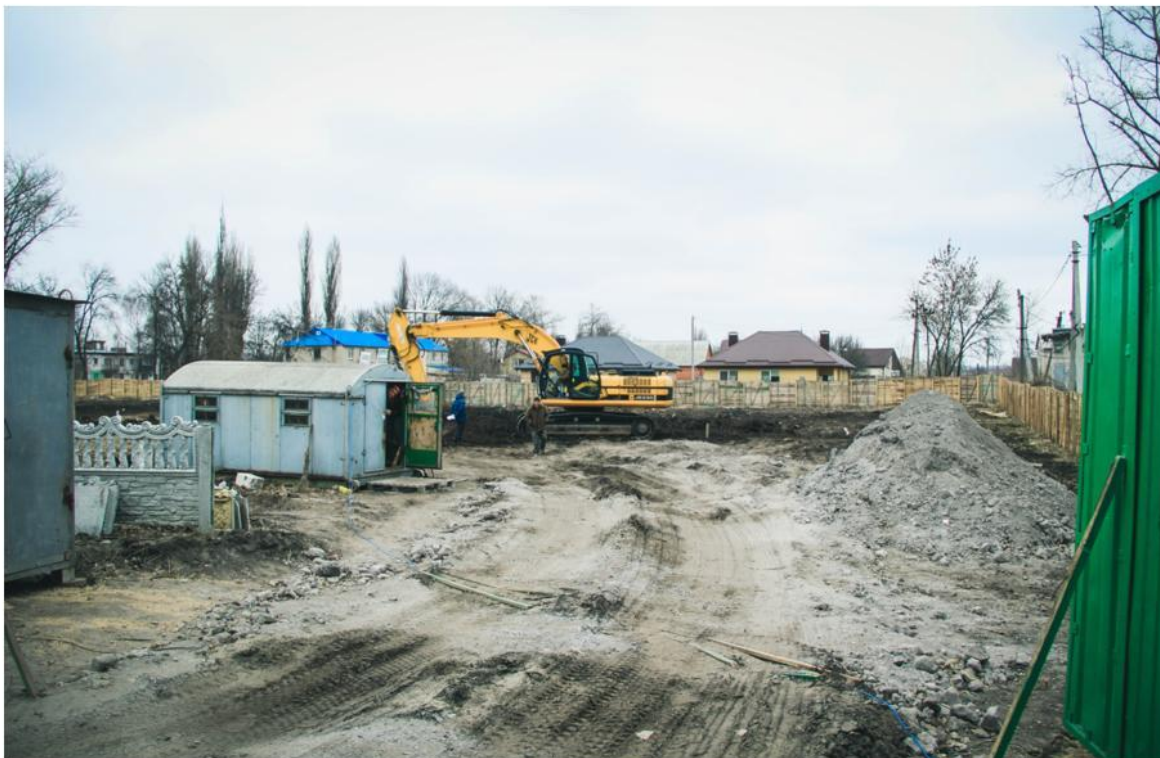
Триває будівництво будинку культури
